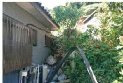
市町村営急傾斜地崩壊対策事業(津久見市)
