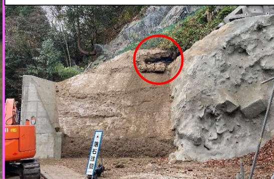
貫通の瞬間！(玖珠町側入口)
