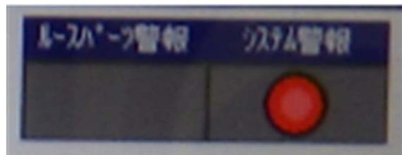
「システム警報」ランプ点灯
