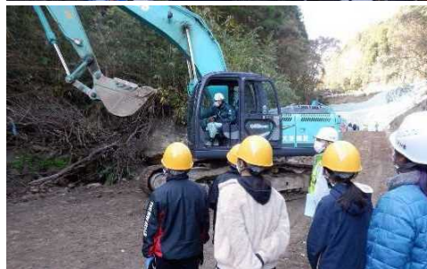
▲町田川災害工事での現場見学
