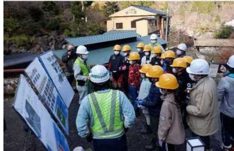
▼国道387号での現場見学
