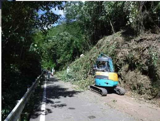
↓伐採作業の様子
