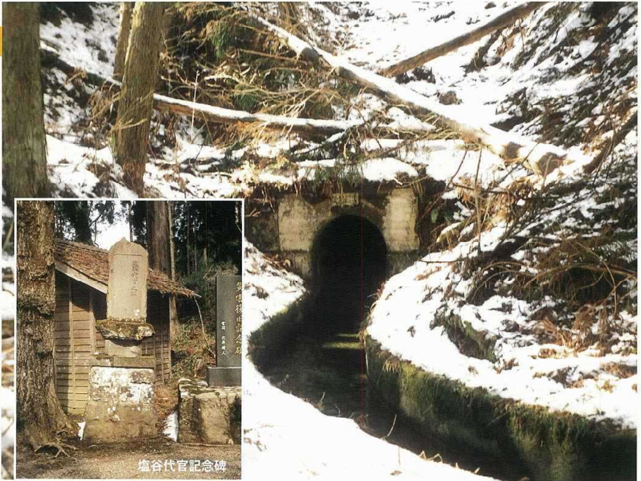
【諸元】 水路延長:全延長10,175m 隧道:750m
