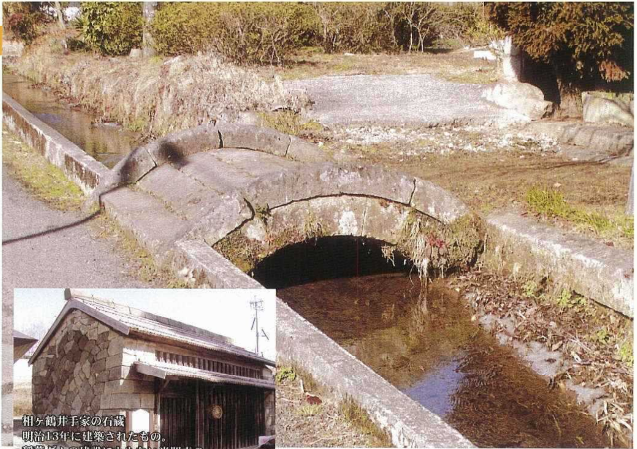
白丹宿場町を通る農業用水。 [諸元] 水路延長:5.5km 断面:0.4m×0.4m ~0.6m×0.6m
