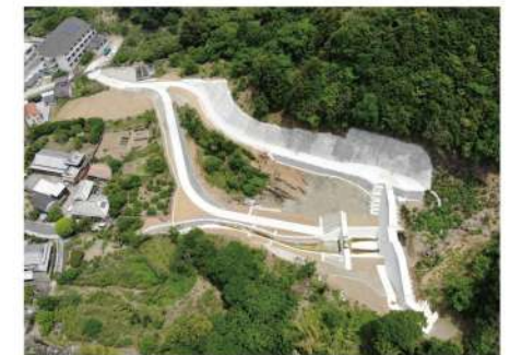
災害関連緊急砂防事業 井無田川1（津久見市）
