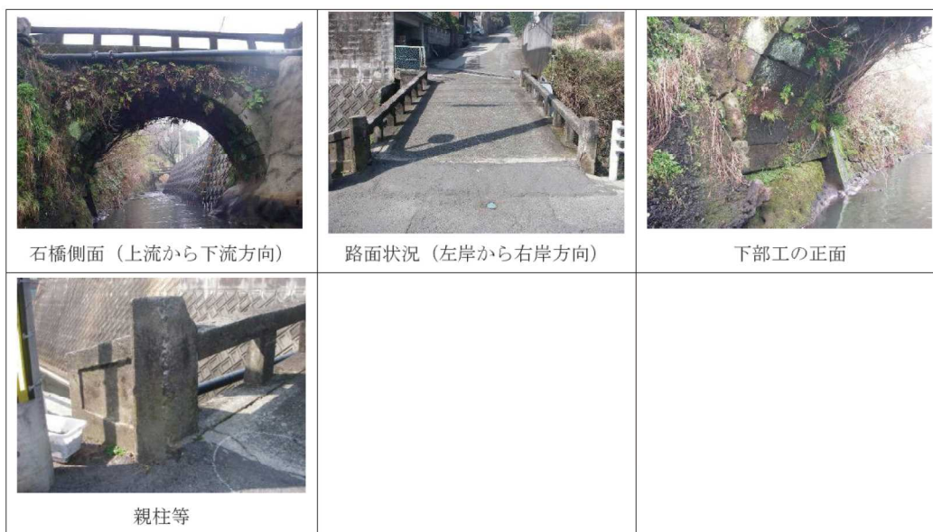
図3.3.1 石橋の正面、側面、下部工、親柱などの写真
