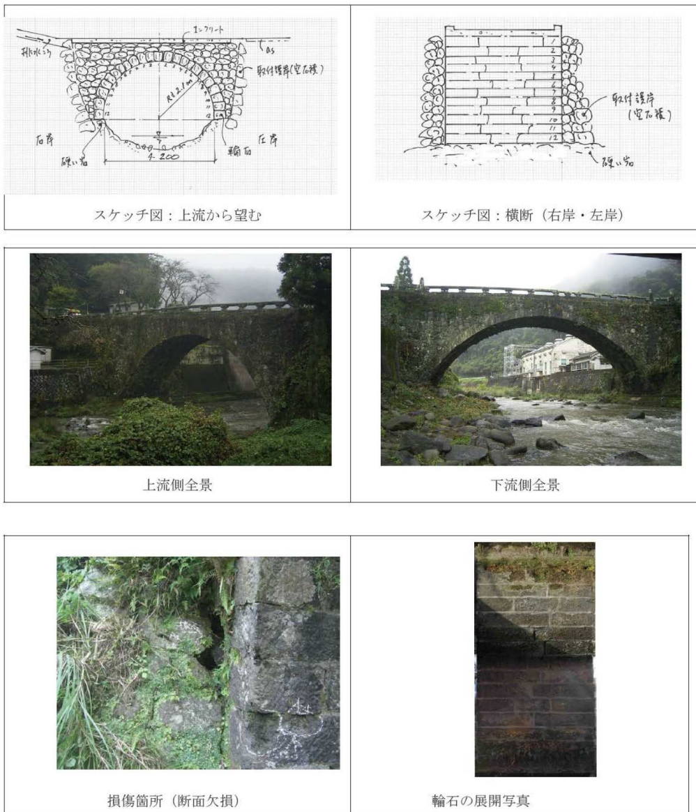
図3.3.2 石橋の損傷スケッチと写真撮影
