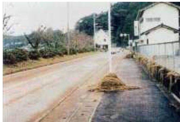
写真3 平成9年9月出水の被災状況 (白杵川 5K/100 右岸)
