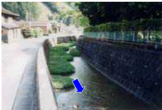
写真 14 小河内川の河川景観 (平成 13 年 7 月撮影)
