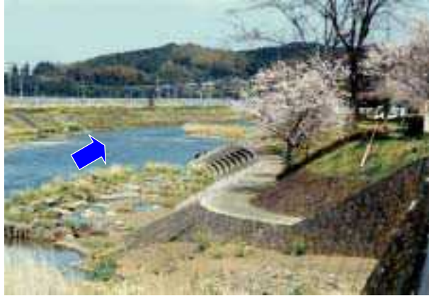
写真7 臼杵川の河川景観（平成12年4月撮影）
