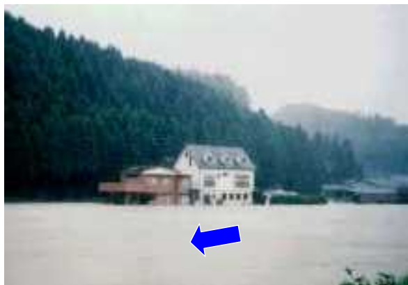
写真2 平成9年9月出水の被災状況 (白杵川 5K/100)
