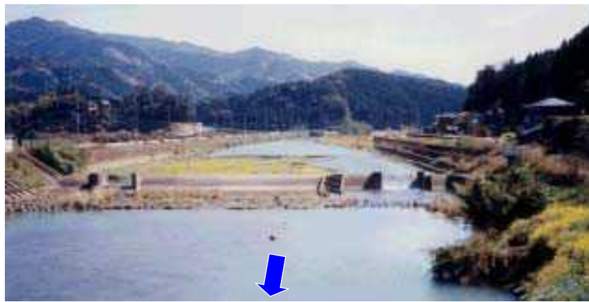
写真6 農業用水を取水している野田堰 (平成12年4月撮影)
