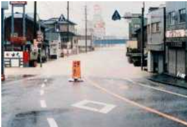
写真4 平成9年9月出水の浸水状況 （土橋アンダー）
