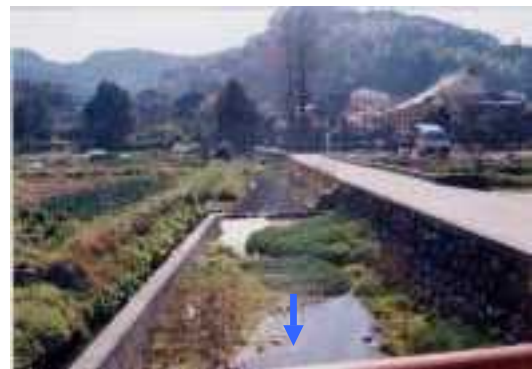
写真 18 独歩川の照恩寺付近の景観 (平成 12 年 4 月撮影)
