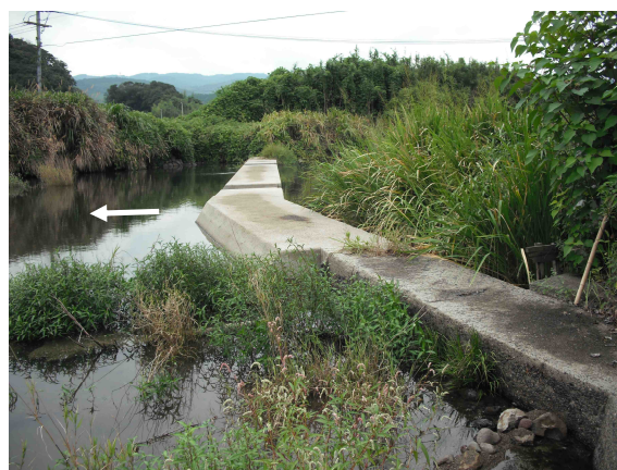
写真 2-2 川曲頭首工 (高山川：杵築市高山)
