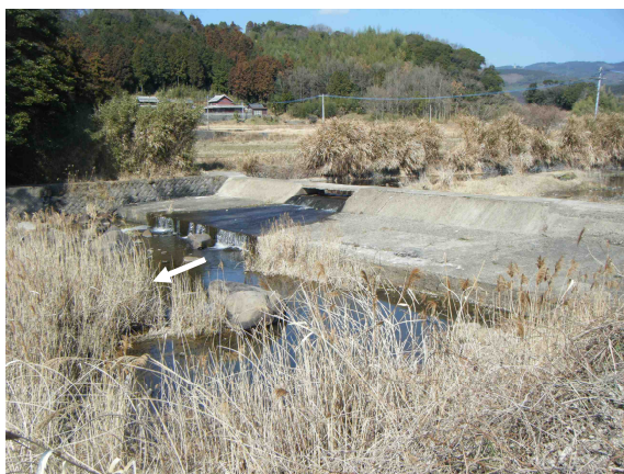
写真 2-1 山迫頭首工 (高山川：杵築市杵築)
