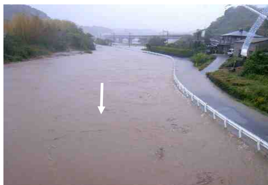
写真 1-3 平成9年9月出水(若宮橋上流)
