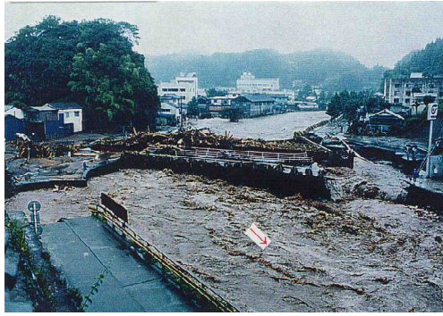
写真 2-1 平成 2 年 7 月出水の状況 (稲葉川豊岡橋付近)
