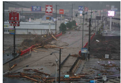
写真 2-4 平成 24 年 7 月出水の状況 (玉来川桜瀬橋付近)
