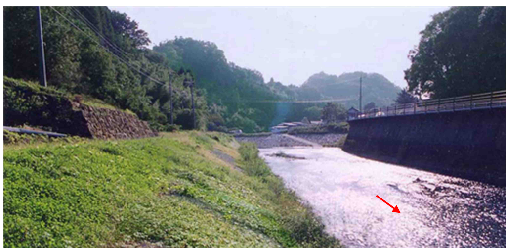
写真 4-1 整備状況（2K300 付近）
