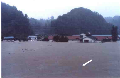
写真 2-3 平成 2 年 7 月出水の状況 (矢倉川 支援学校付近)
