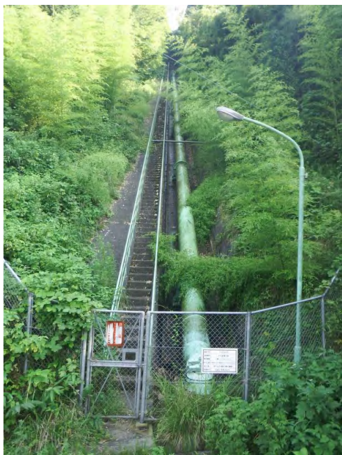
写真 2.2.3 発電用水 (花合野川発電所)
