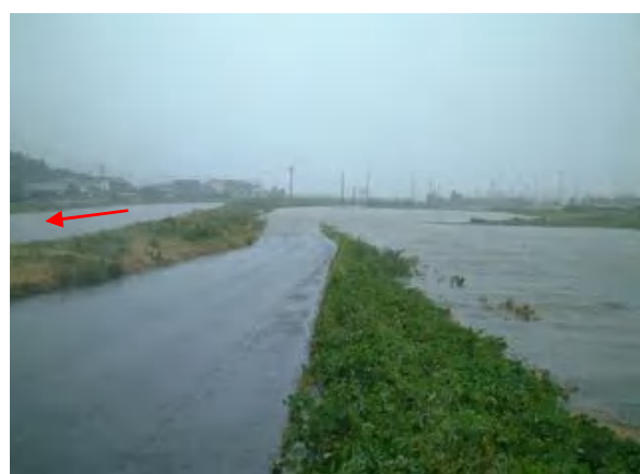
写真 2.1.4 大分川(湯布院地区)の内水被害状況 (平成 16 年 10 月)
