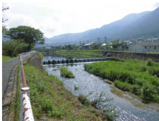
写真 2.2.2 農業用水 (山崎井堰・湯布院地区)
