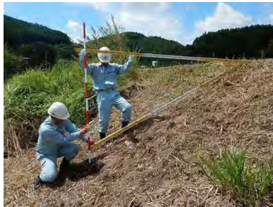
写真 2.1.5 堤防の点検状況(大分川)
