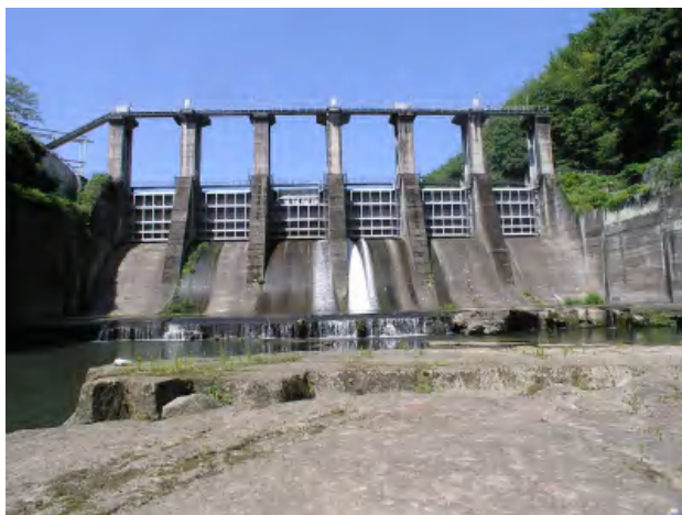
写真 2.2.4 発電用水 (篠原ダム)
