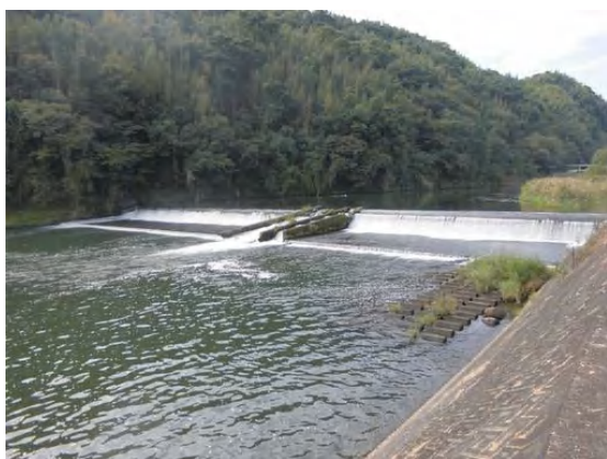
写真 2.2.1 農業用水 (享保井堰・挾間地区)
