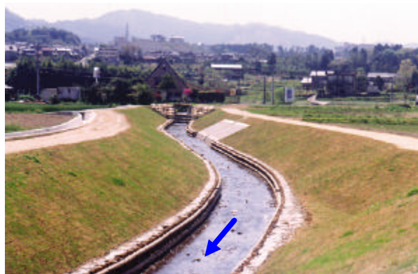
写真 11 整備状況 (0k/200 付近)
