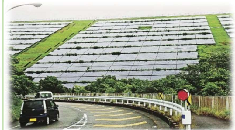
南紀白浜空港（空港のり面）
