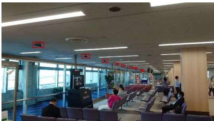
＜エアロシールド設置＞
