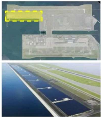
関西国際空港（空港場内・売電）
