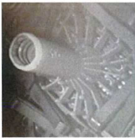
【原子炉格納容器内】
