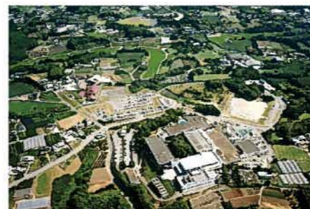
川崎工業団地
