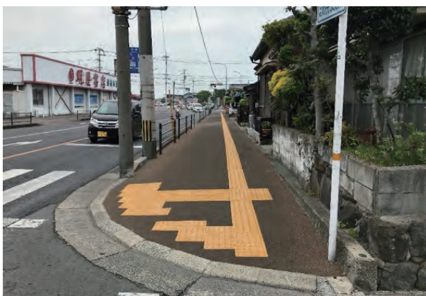
歩道の段差解消、点字誘導ブロックの敷設
