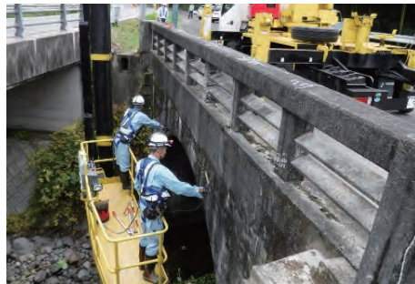
橋梁の点検状況
