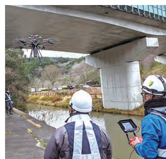
ドローンによる橋梁点検
