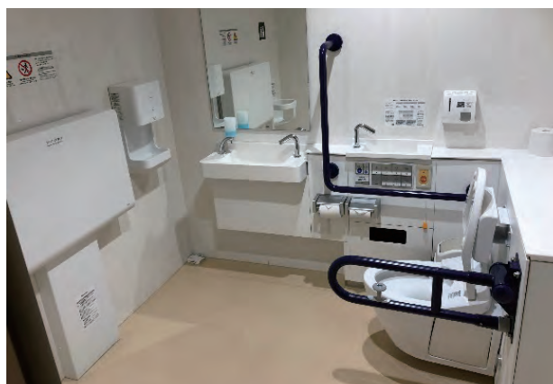
多目的トイレの設置
