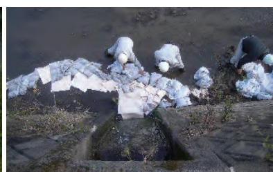
河川に流失した油が流下しないよう作業
