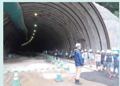
工事中のトンネルに初めて入ったよ！
