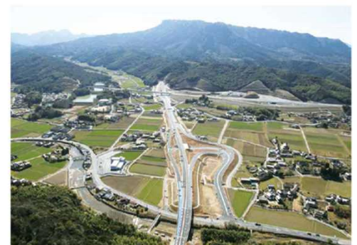
朝日田方向的中津日田公路正在修建中
