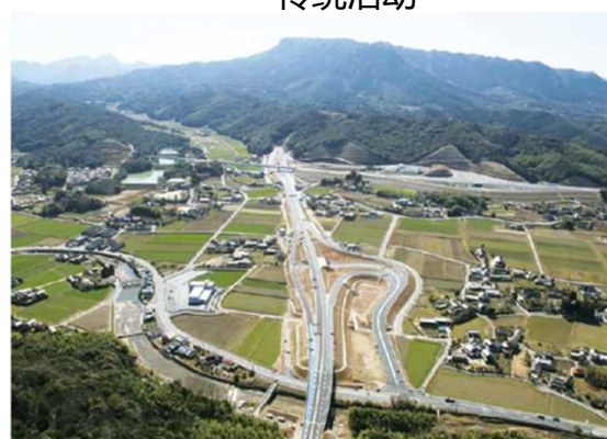
中津日田公路正在修建中
