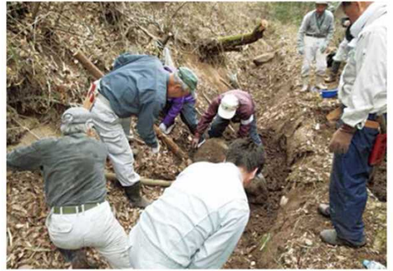
小规模村落救援队修复水路
