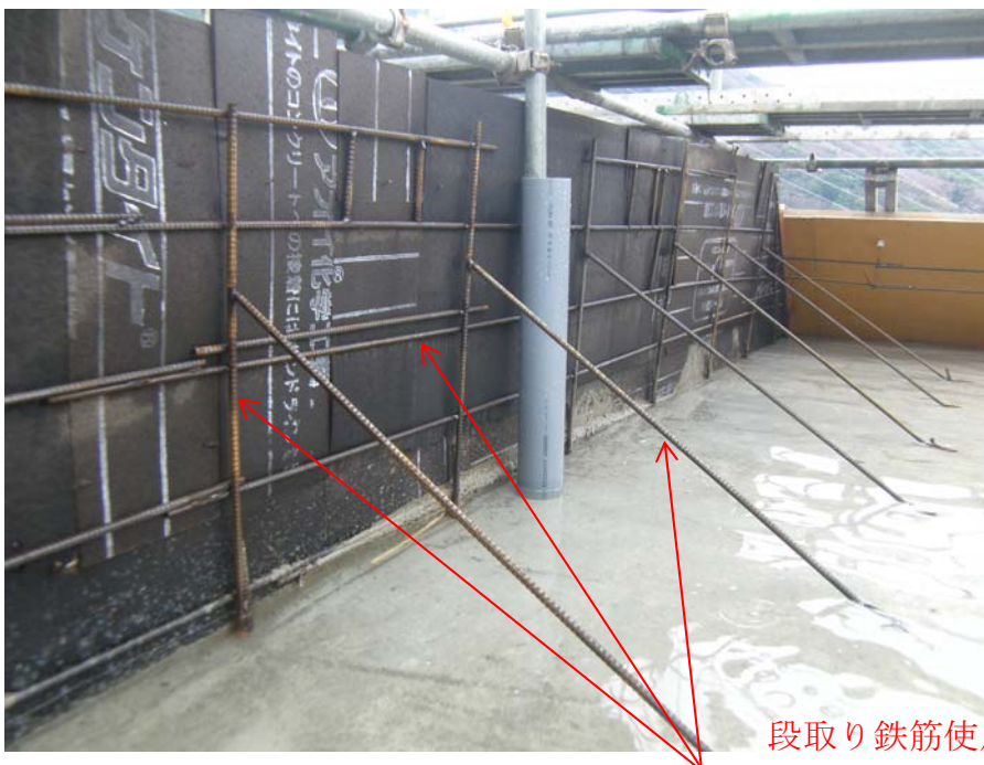
(段取り鉄筋使用例)
