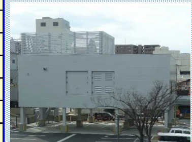
設備防災対策 (県庁舎別館)
