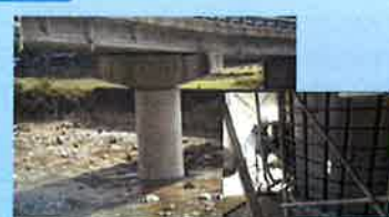
下部工の耐震化(橋脚の補強)
