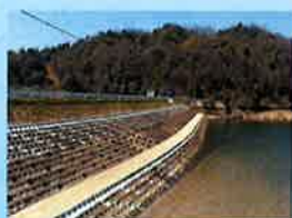
耐震化整備(対策後)
