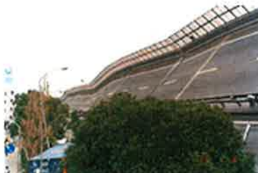
阪神間連絡路の高架橋の倒壊 (写真提供：神戸市)
