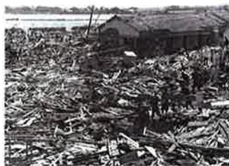
伊勢湾台風の被害状況 (写真提供：愛知県)
