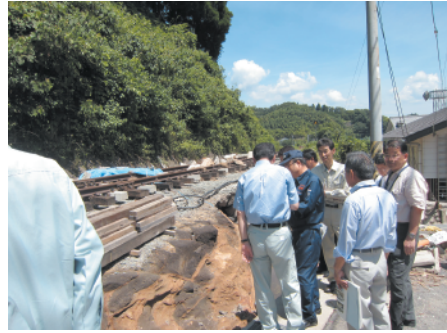
竹田総合庁舎及びその周辺の被災状況を調査
