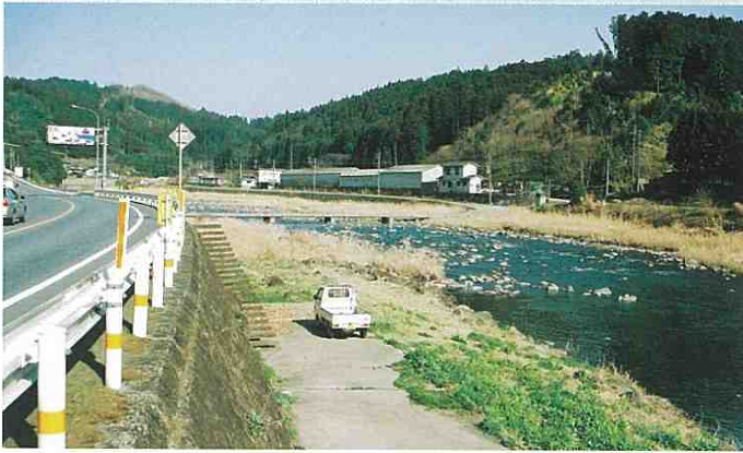
当時の堰は、写真中央の沈み橋付近にあったそうです
