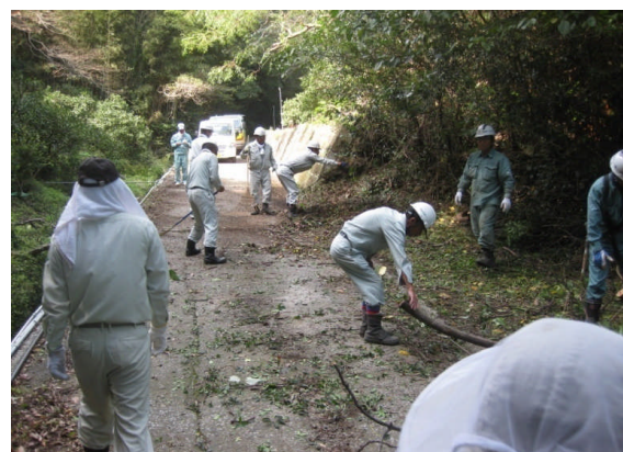
農道を覆っていた枯れ木も撤去
