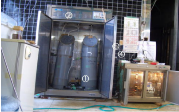
写真2 堆肥化システムの概要
