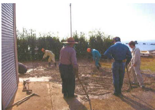
一部にコンクリートを敷設
