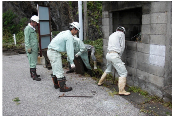
側溝蓋の撤去
