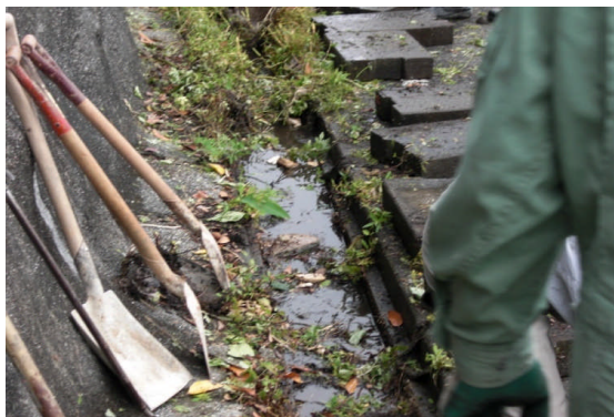
側溝内の状況
