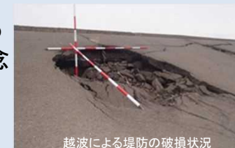
越波による堤防の破損状況
