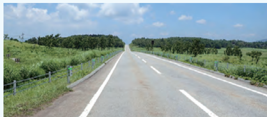
景観に配慮した防護柵に更新
