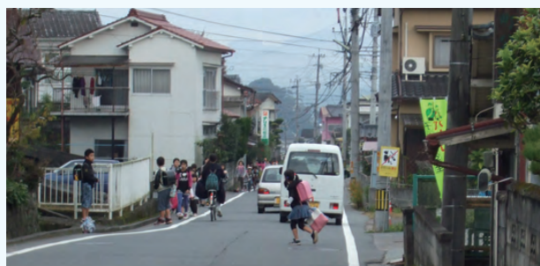
自歩道等の新設が必要な街路((都)銭淵大宮線:日田市)
