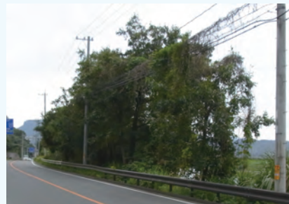
眺望を阻害する樹木 国道212号（中津市山国川河岸）
