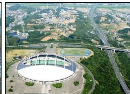
大規模な広域防災拠点(大分スポーツ公園)
